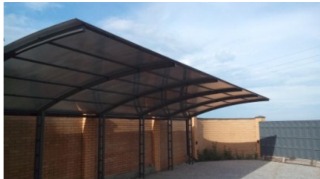
Система крепления «Актив» Материал - алюминиевый сплав АД31 Т5, (6061Т5) Метиз – нержавейка А2;
