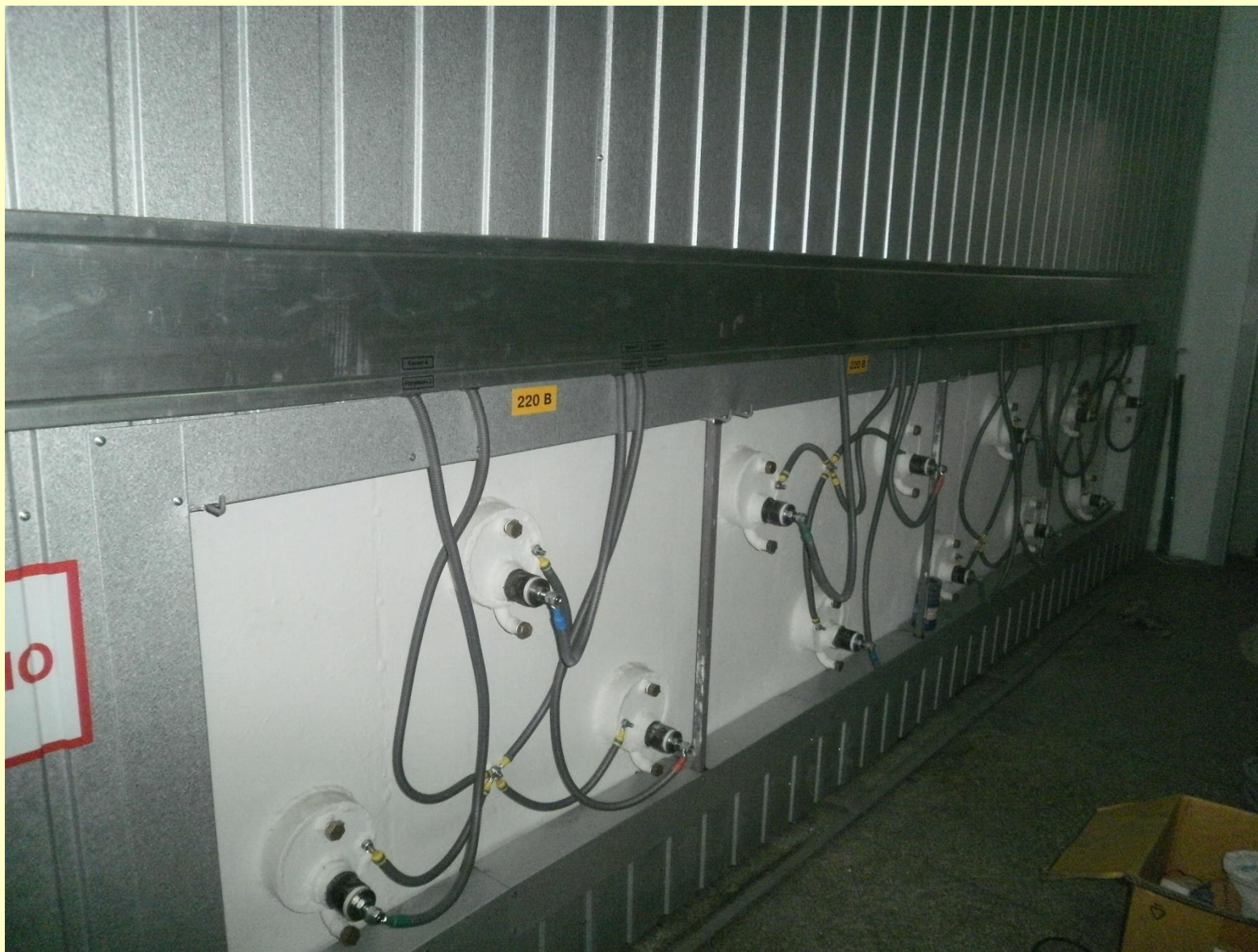
Теплоаккумулятор. Зона нагрівачів НЕЛ-15
