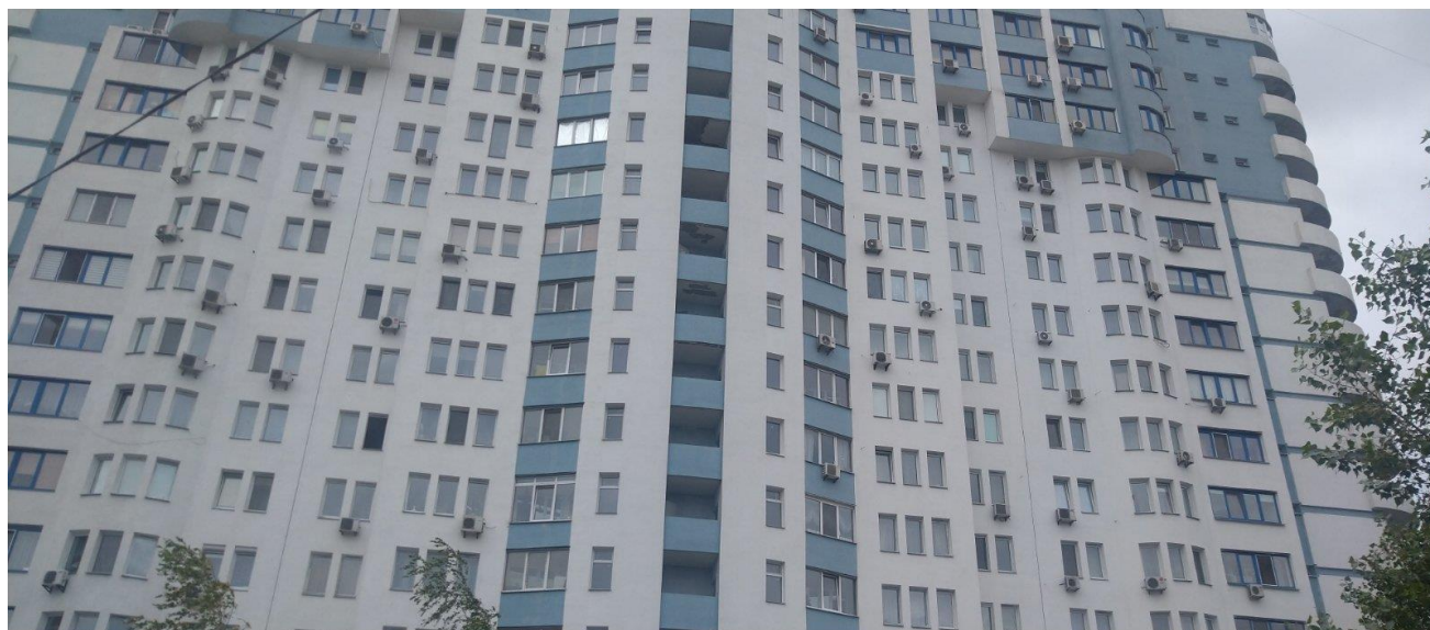
Рисунок 4.1.1. Фрагменти фасаду будівлі
