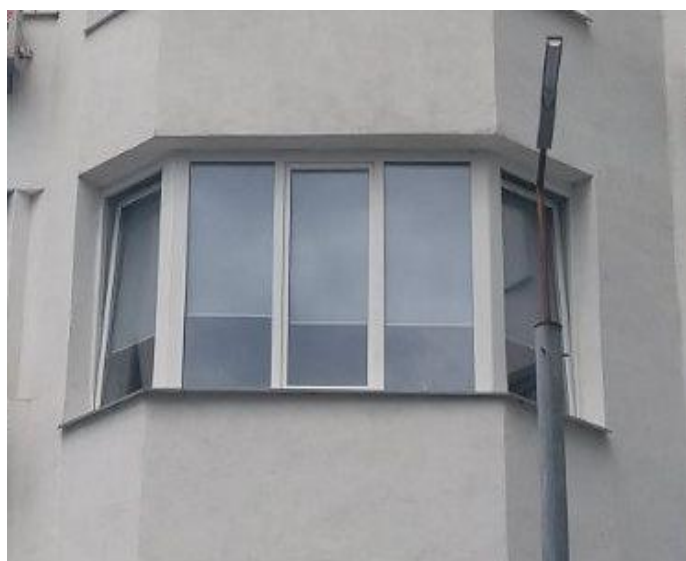
Рисунок 4.2.1. Вигляд вікон будівлі
